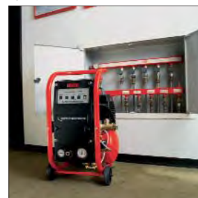
Промывка системы отопления пола
