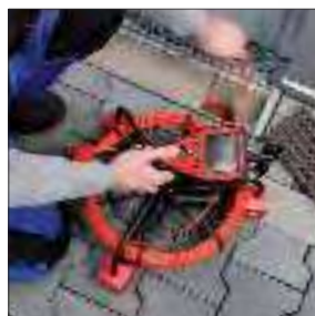
Обследование ливневых труб
